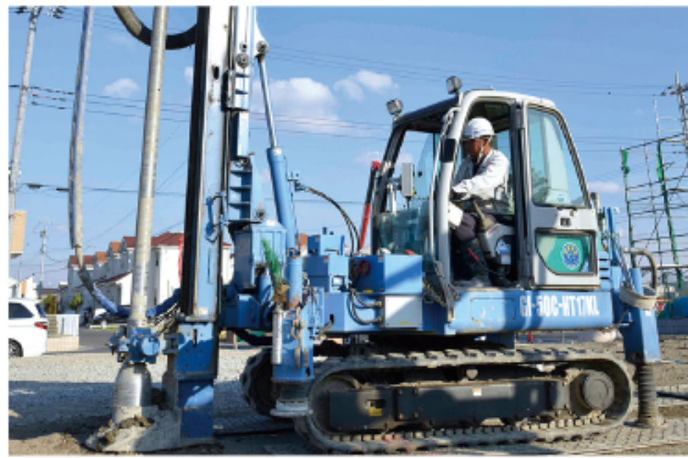
敷地調査・地盤改良
